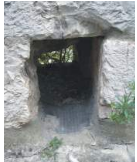
Exutoire pour évacuation de eaux
