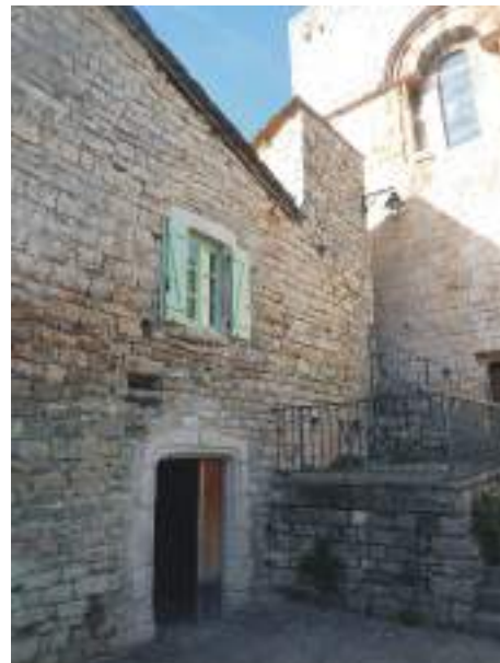
Élévation sur cour
