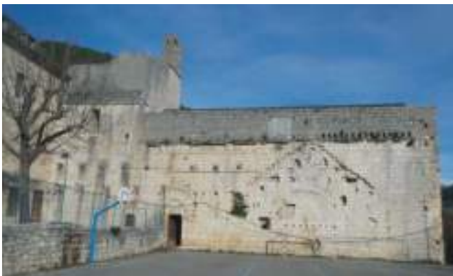
Élévation Ouest dégagée
