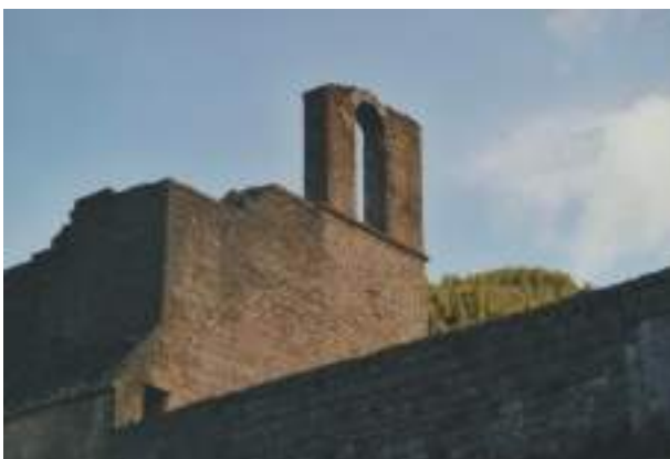
- Ancienne abbaye. Façade Sud, détail - tirage photographique - Franck Genestoux - 2003 AP80L028729
