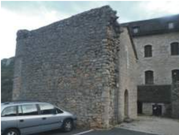
Maçonnerie de tout-venant de l'ancien rempart
