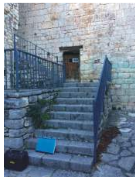
B. Escalier à double volée
