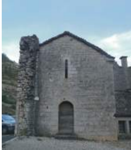
Appareil assisé sur pignon Est de la chapelle
