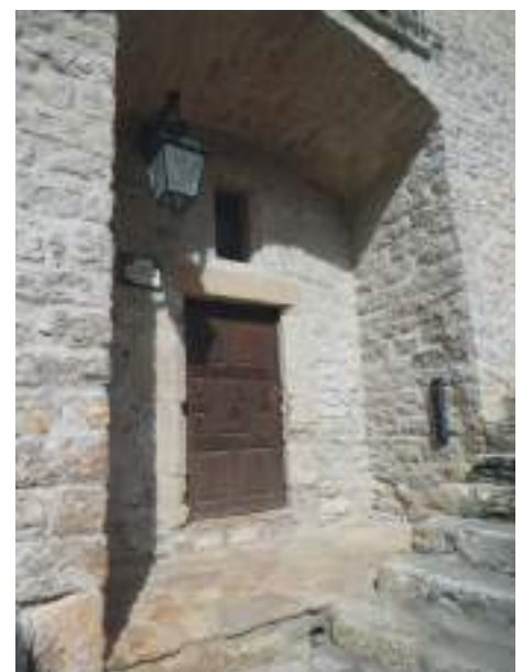
Arcade percée dans l'épaisseur du gouttereau
