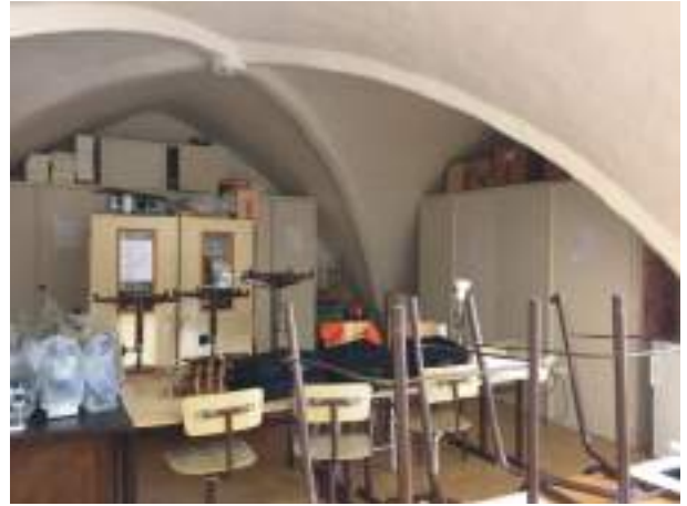
Étage de la salle voûtée entresolée
