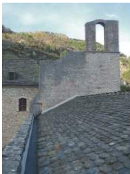
Ouïe percée sur l'élévation Sud de la tour
