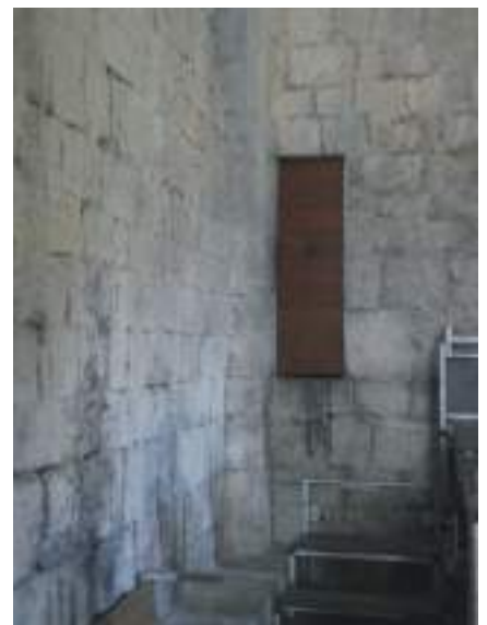
6. Porte d'accès à la terrasse
