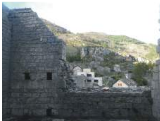
Rejointoiment hydraulique des parements "intérieurs" de la tour-donjon
