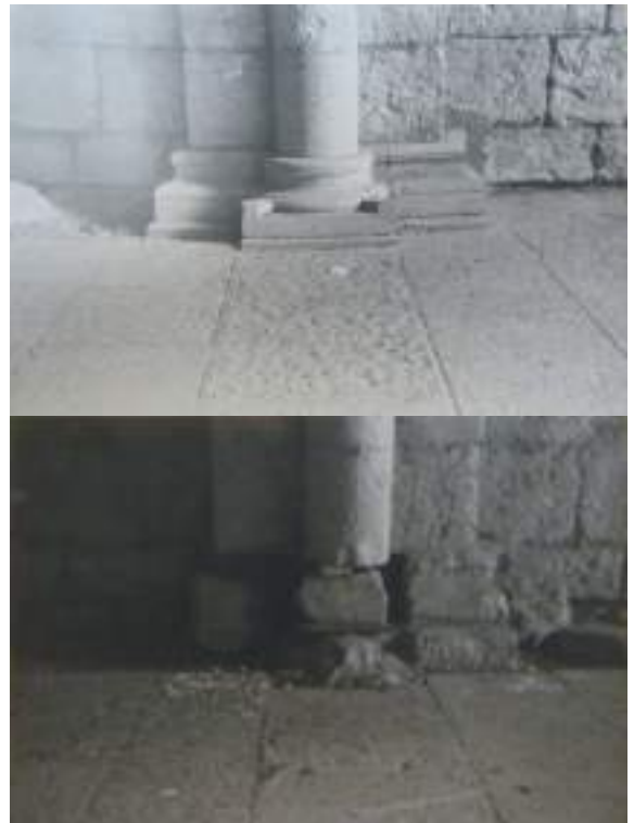
Restauration engagée et inachevée : "Une réfection des bases a été effectuée il y a plusieurs années. Pour assurer une continuité de restauration, il est prévu de rétablir les bases dont il subsiste l'indication précise de mouluration, le fragment ancien étant conservé intact" - Michel Dufoix, A.C.M.H., 1981 - Médiathèque de l'Architecture et du Patrimoine
