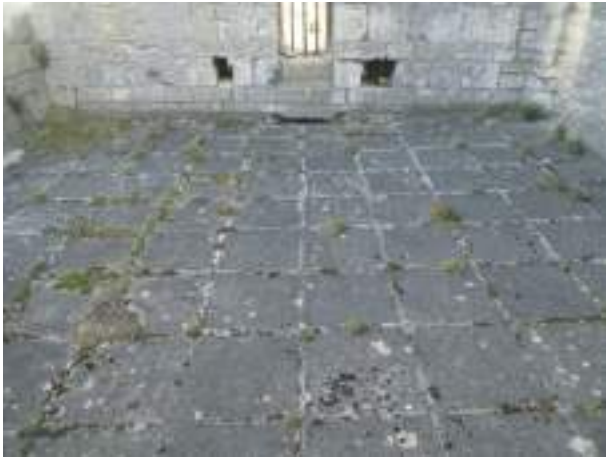
Terrasse en dalles ciment avec forme de pentes pour évacuation de eaux
