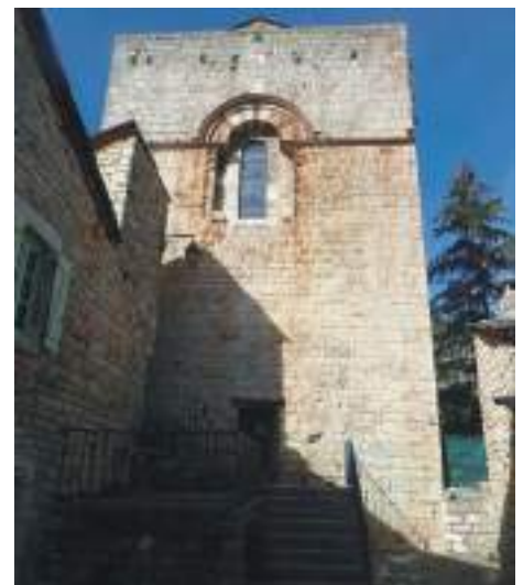
Maçonnerie de moellons équarris de l'élévation Sud
