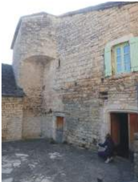
Élévation sur cour
