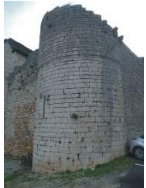
Maçonnerie de moellons équarris
