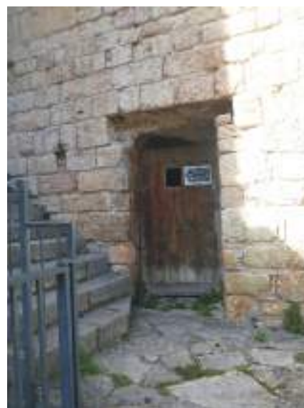
c. Baie remaniée en porte
