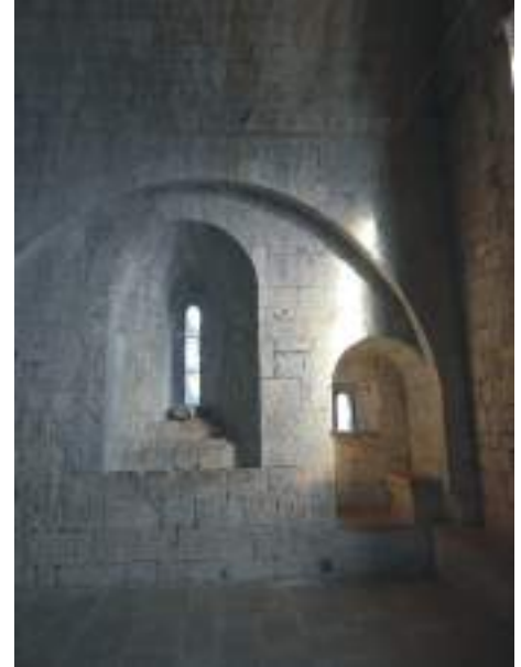
Percements du gouttereau Est
